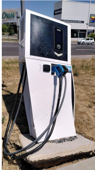
Figuur 1: onvoldoende bescherming tegen aanrijding
